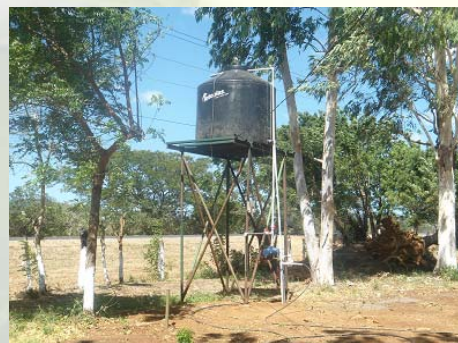
Ilustración 43. Tanque de almacenamiento de agua potable.
